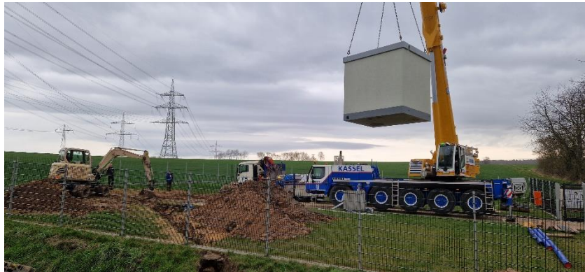
Brunnenabschlussbauwerk Brunnen IV, Balkenröderweg
