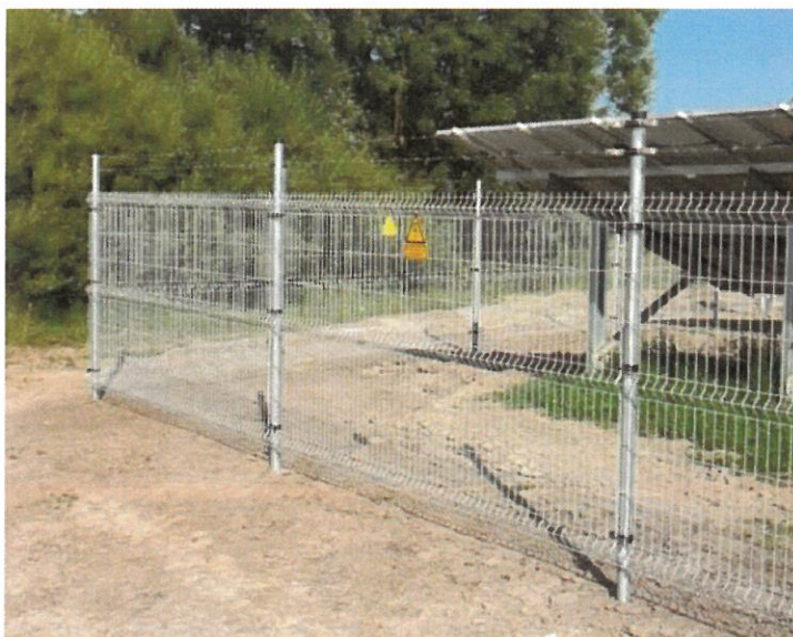
Beispiel einer Zaunanlage 2,5 m Höhe inklusive Übersteigenschutz
