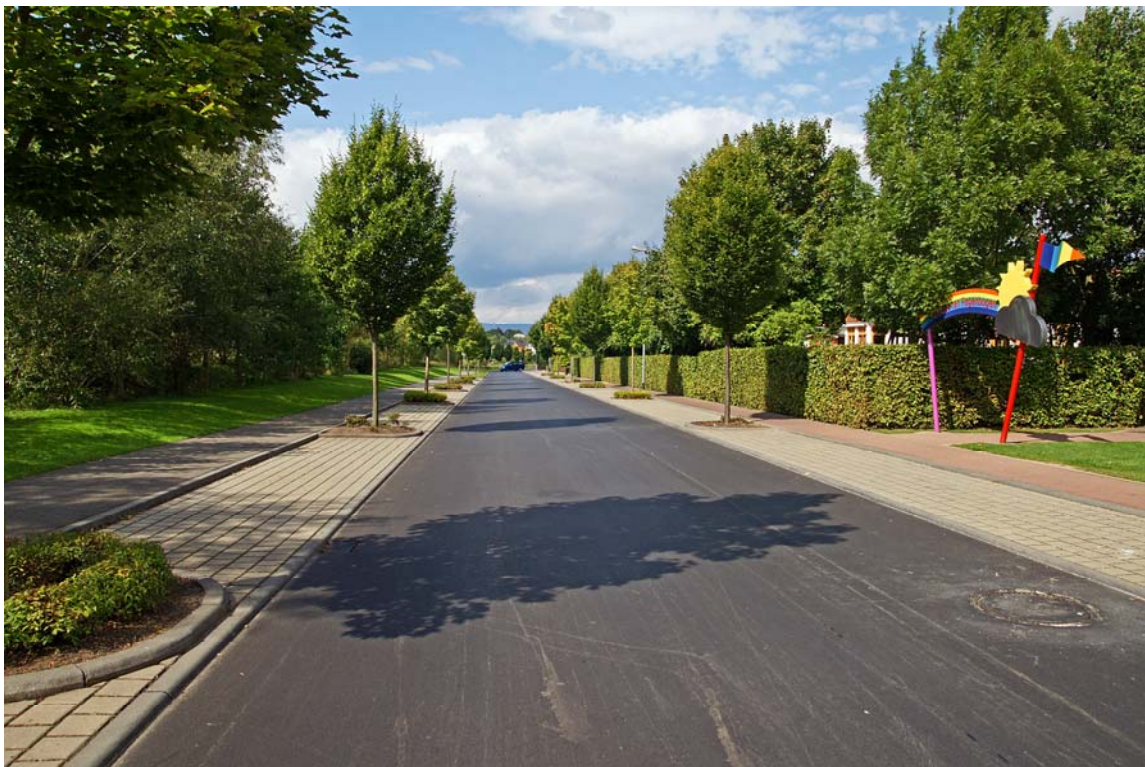
(Cornelius-Gellert-Straße nach der Fertigstellung)
